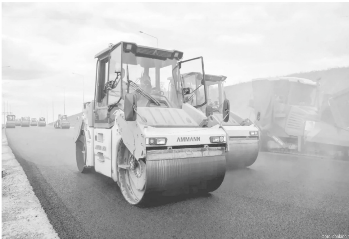
Дорожники Ростовской области приступают к ремонтным работам
